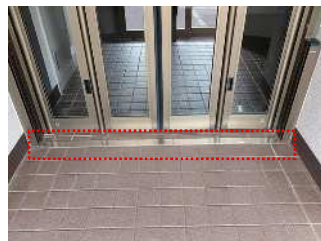
脱着式止水版(左)・止水版設置時の漏水防止用ステンレス版(中)
