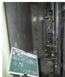
ステンレス製の立管に改修
