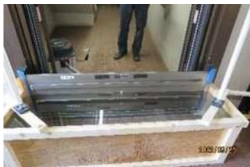
脱着式止水版(左)・止水版設置時の漏水防止用ステンレス版(中)
