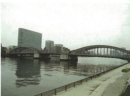
31 勝鬨橋 Kachidoki-Bashi Bridge
