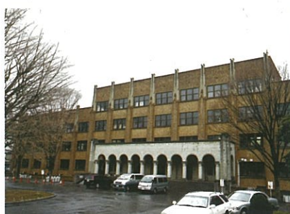
61 東京大学農学部3号館 The University of Tokyo Faculty of Agriculture Bldg.3
