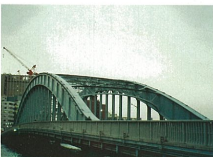
32 永代橋 Eitai-Bashi Bridge
